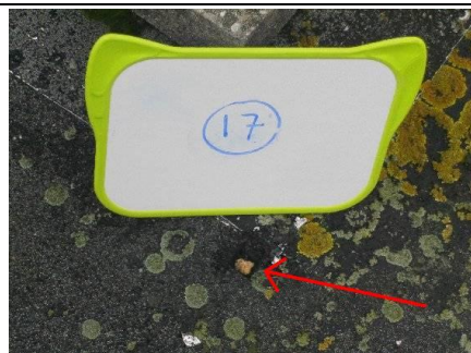
Photo n° PH05 Localisation : Toiture - Terrasse Ouvrage : Toiture, terrasse et étanchéité - Bardeaux bitumé (type Shingle) Partie d'ouvrage : Bardeaux bitumé Description : Bardeaux bitumé Localisation sur croquis : PH05
